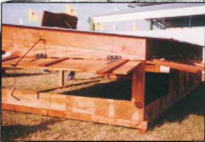
f Foto 5.20. Reparos.
