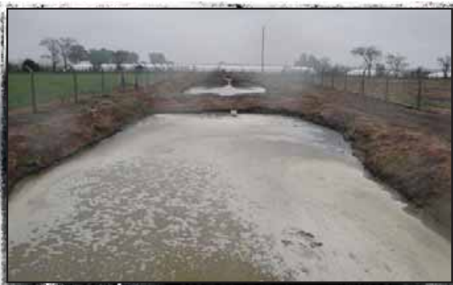
f Foto 12.12. Laguna de estabilización de la EEA Rafaela (INTA).
